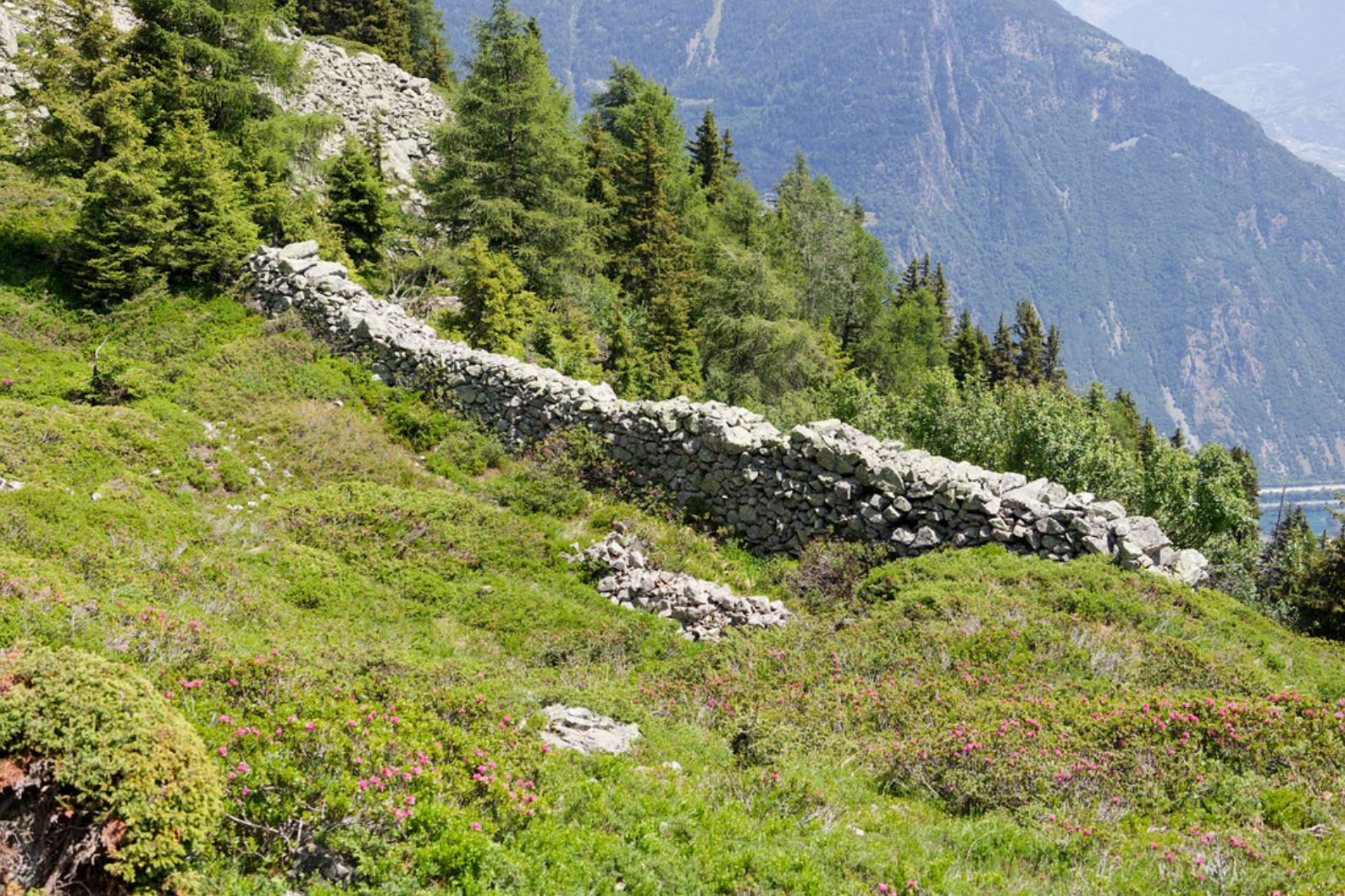
Un mur de protection contre les avalanches.
