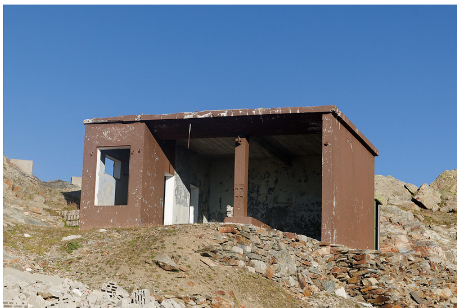
Le vestiges de l'arrivée du télésiège de la Chenalette.
